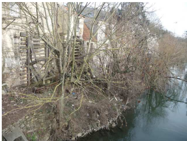
Figure 7 : Vue des berges de l'Yverres depuis le Pont
