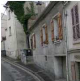
14 rue de l'Eglise
