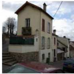
16-18-20-22 rue de l'Eglise
