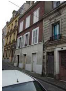
2 bis rue de l'Eglise
