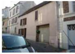
8 rue de l'Eglise
