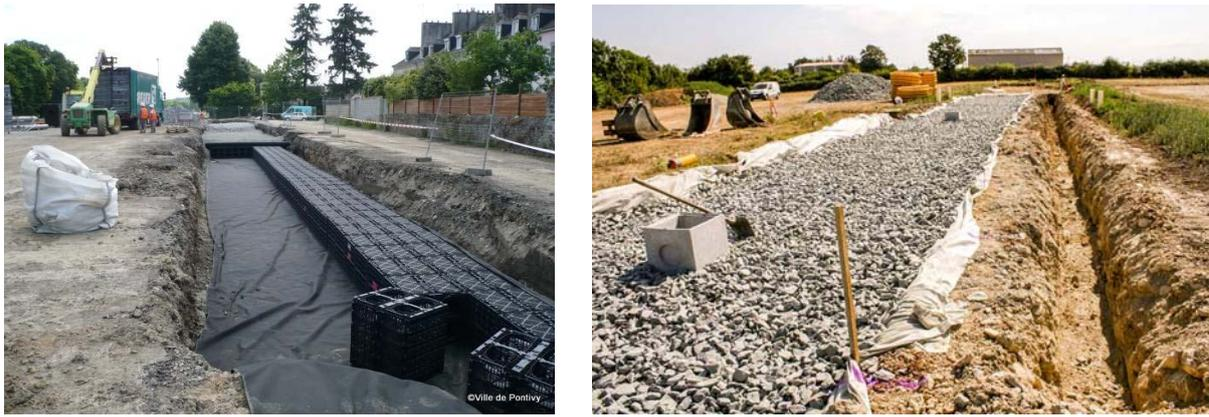
Figure 60 : Installations de deux chaussées réservoirs
