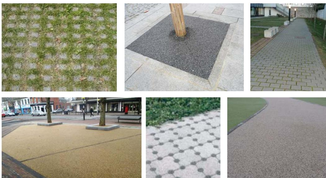
Figure 57 : Exemples de revêtements poreux (Source : proba.com)
