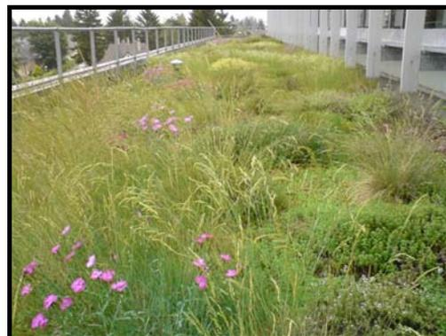
Figure 55 : Exemples de toiture végétalisées dite de type semi-intensif (Source : toiture-vegetalise.com)
