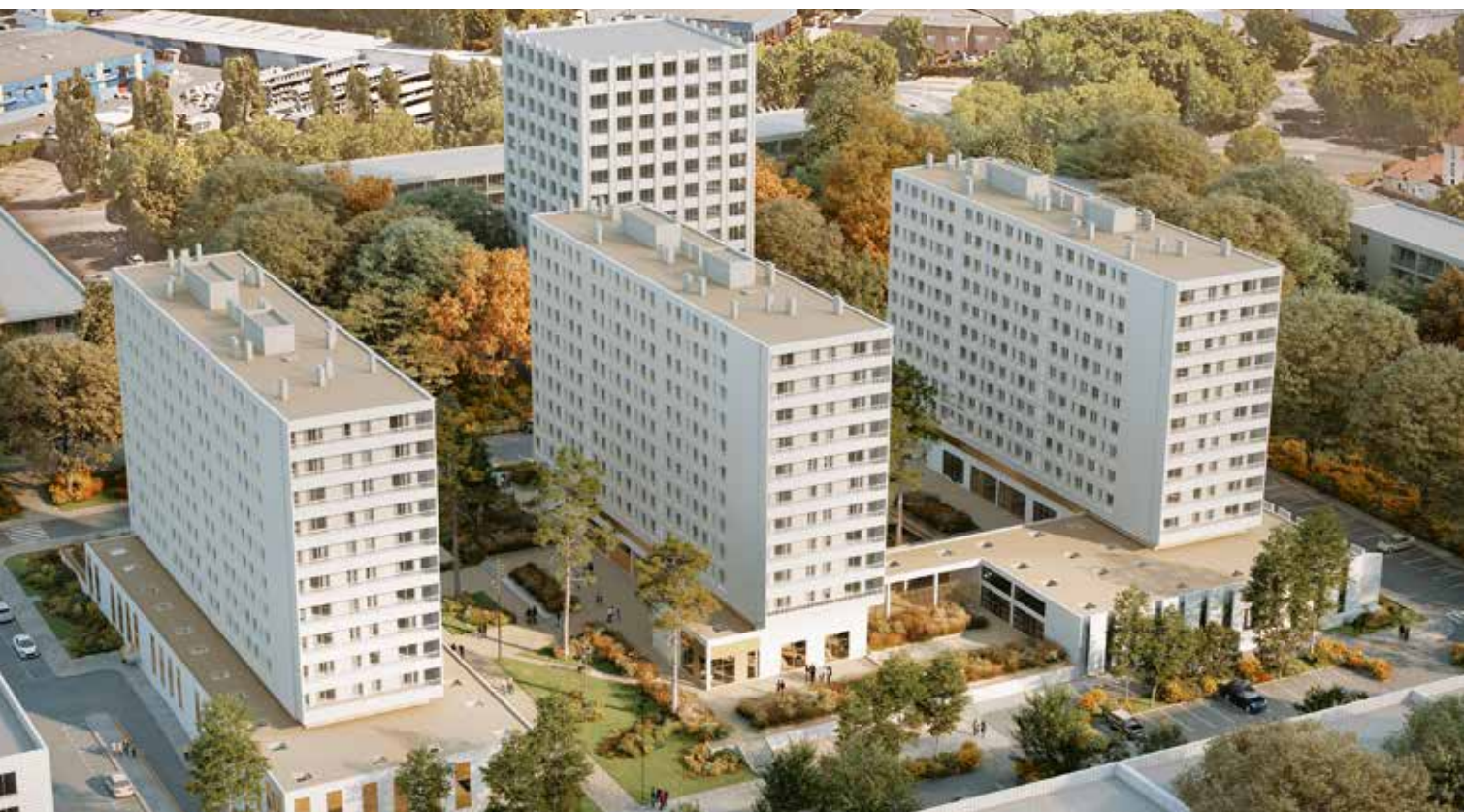
Restructuration de la dalle des Gravier et réhabilitation de ses 270 logements (CDC Habitat)
