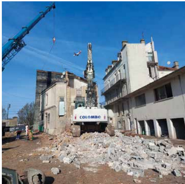
Démolition du Foyer Cocteau et de l'ancien parking Leduc
