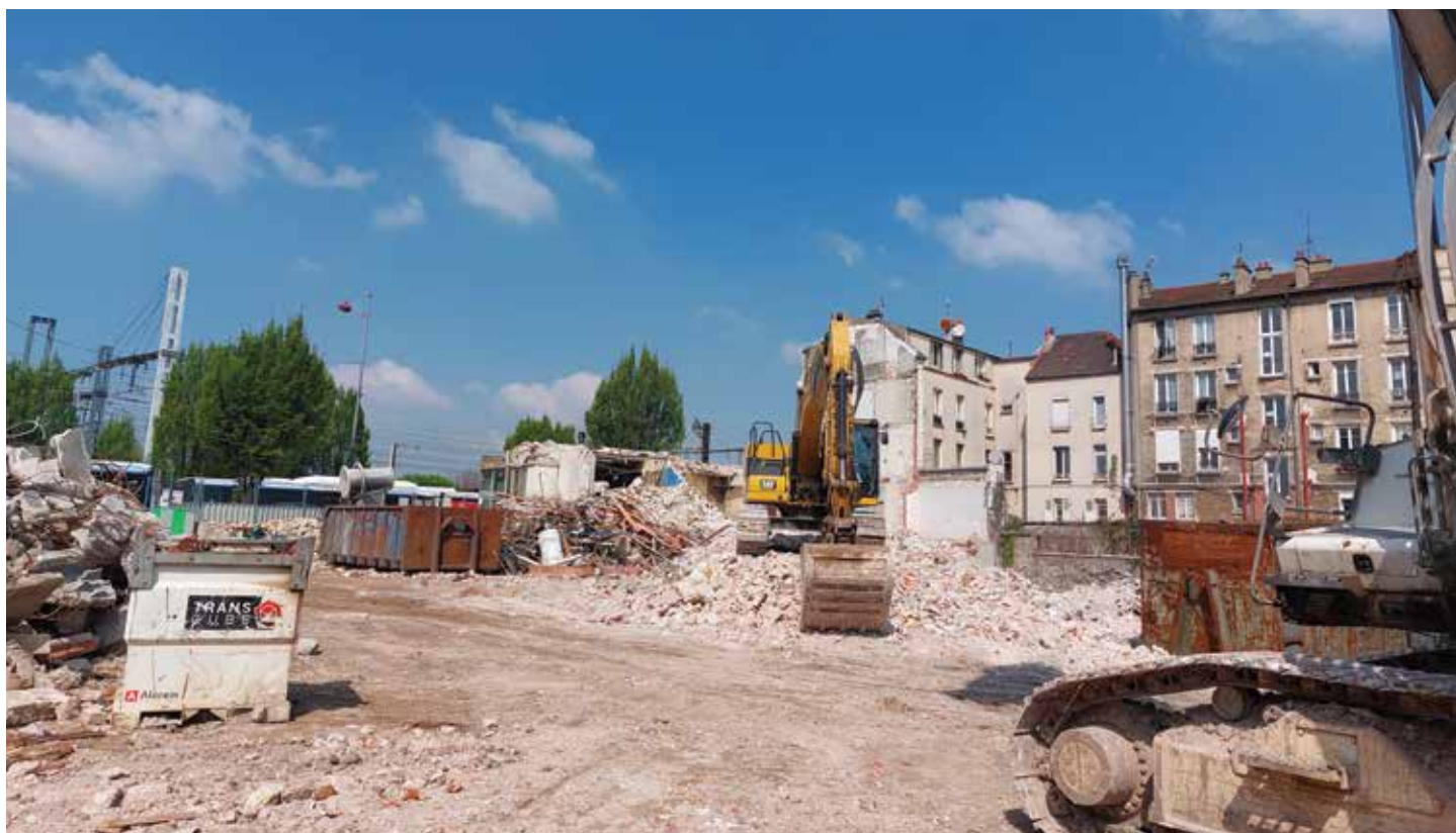
Pendant plusieurs mois, les ouvriers ont travaillé à faire place nette pour les futurs travaux de Carnot 1
